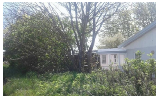
Foto 9. – bør undersøges for risiko.
