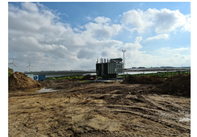
Foto af transformator i anlægsfasen
