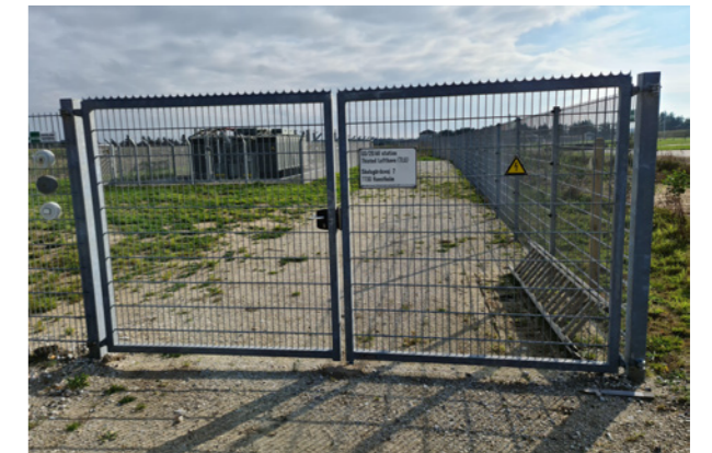
Eksempel på fritstående transformator og hegn.
