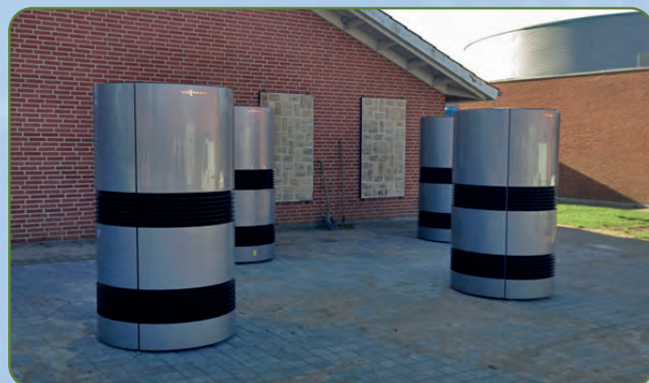
Varmepumper på Tåsingskolen, afdeling Sundhøj.
