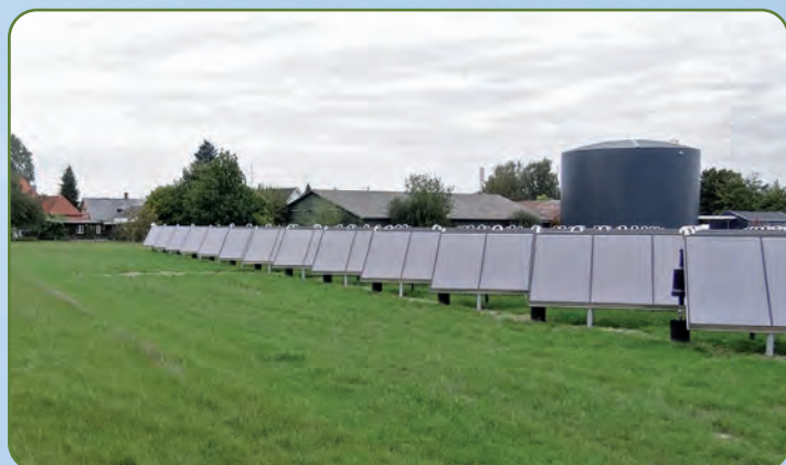
Solfangeranlæg ved Skårup Fjernvarme.
