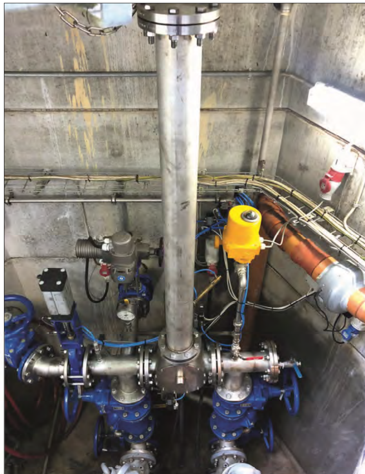
Kort før årsskiftet blev den automatiske rensesgris-afsender monteret i en pumpestation, og er herefter blevet klargjort til drift.
