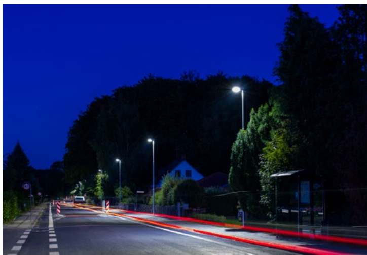
Kogtvedvej med ny LED belysning
