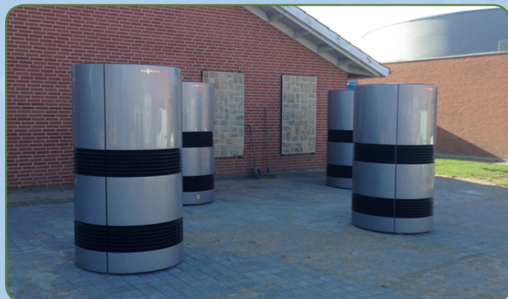
Varmepumper på Tåsingskolen, afdeling Sundhøj.
