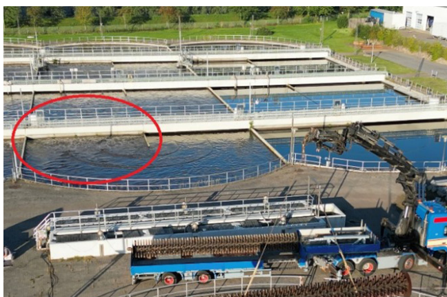
Gamle beluftningsrotorer løftes op af procestanke. I baggrunden ses en beluftningsrotor i aktion.
