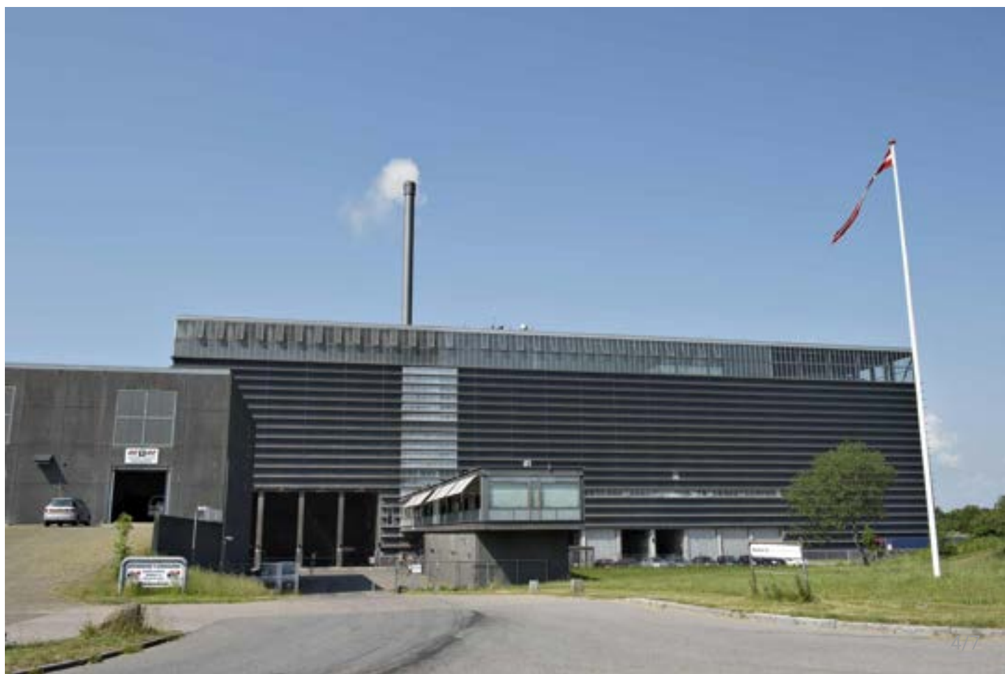
Svendborg Kraftvarmes karakteristiske bygning ligger på Bodøvej i udkanten af byen. Bygningerne skal overdrages til Svendborg Fjernvarme. Arkivfoto: Kim Rune
