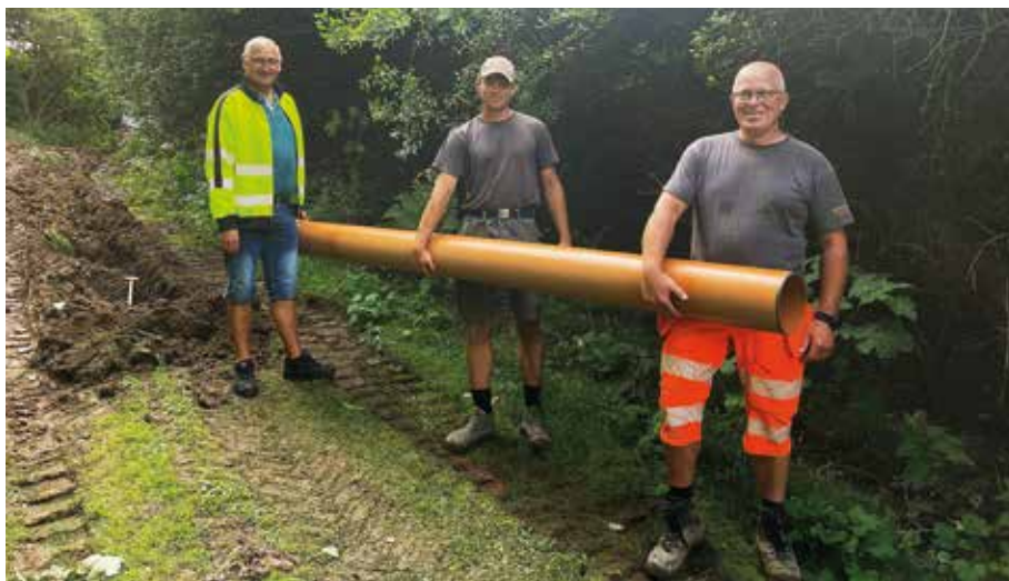
Installation af PVC-rør i Lemvig Vand. Foto: Michael Christensen, Klimatorium.
