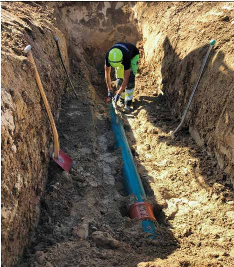
Installation af PP-gravitationsrør hos Novafos. Foto: Marlene Halkjer, Novafos.
