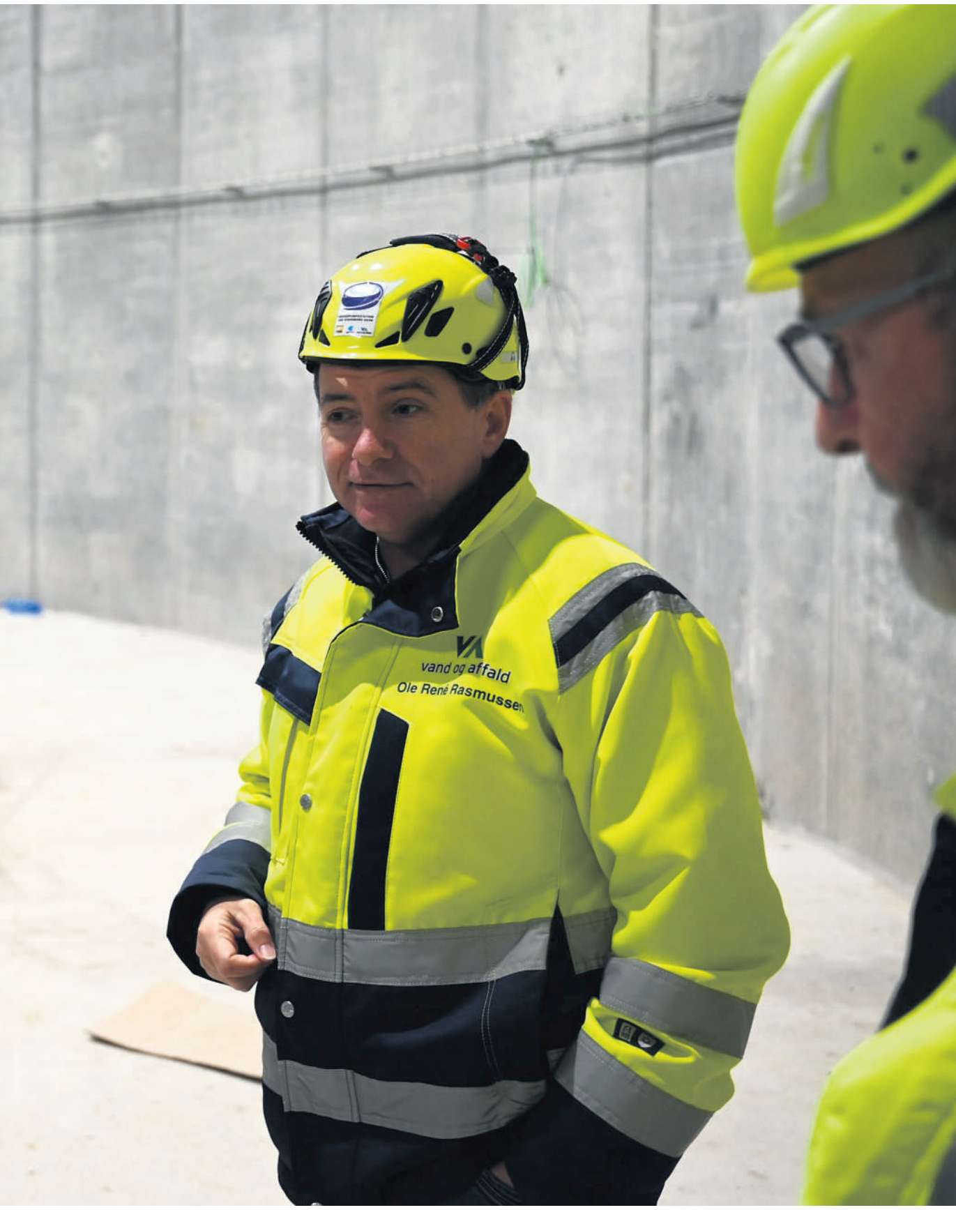
Ole René Rasmussen fra Vand og Affald i Svendborg ser frem til at den nye pumpestation er klar til foråret. Foto: Anders Røjgaard Fly
